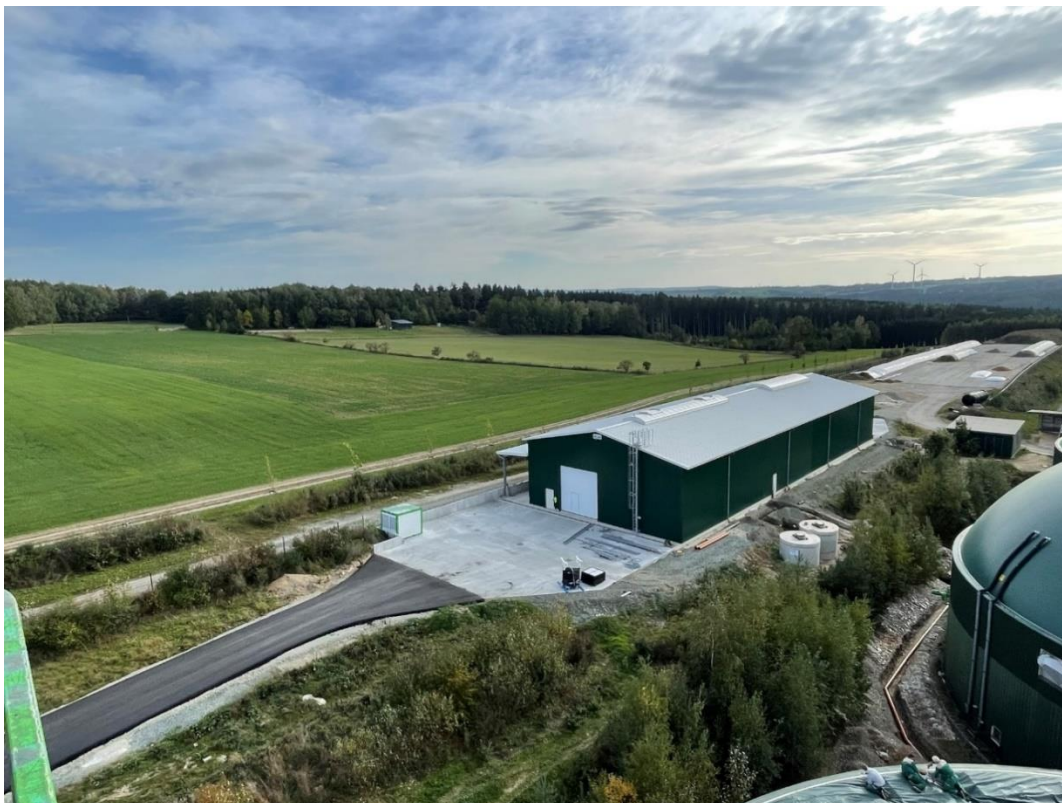
KUMAC-Anlage – Technik- u. Lagerhalle mit Außenanlagen nach Fertigstellung
